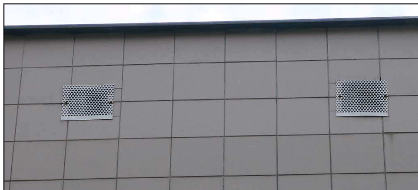
Zakrytí ventilačních otvorů kovovými mříž- kami.
