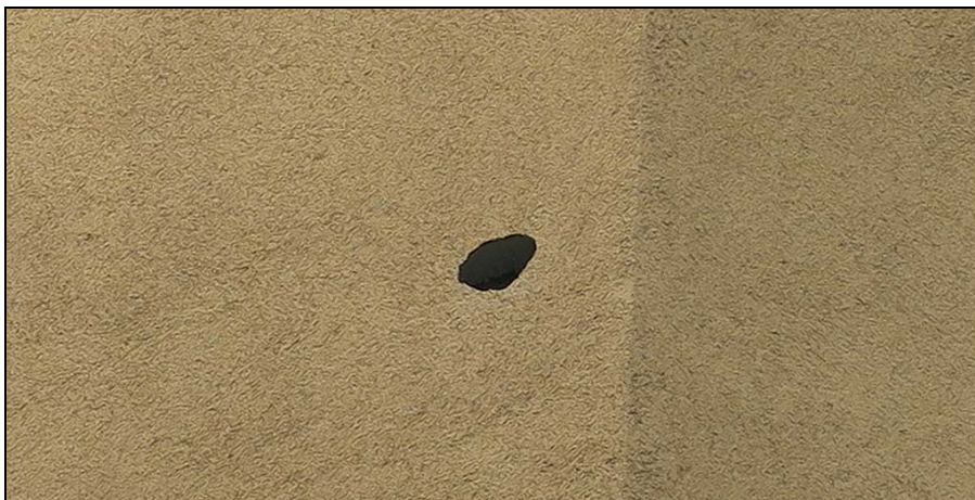
Otvor vytesaný šplhavci do zateplení přístavby východního křídla budovy B.
